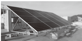
尾田時小校舎屋上
